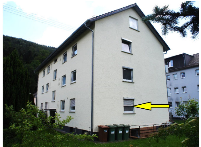
Foto Nr. 4: Ansicht von Norden vom Grundstück (mit Kennz. der Wohnung Nr. 2)
