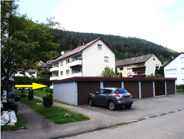
Foto Nr. 1: Ansicht von Süden von der Brennerau (mit Kennz. der Wohnung Nr. 2)
