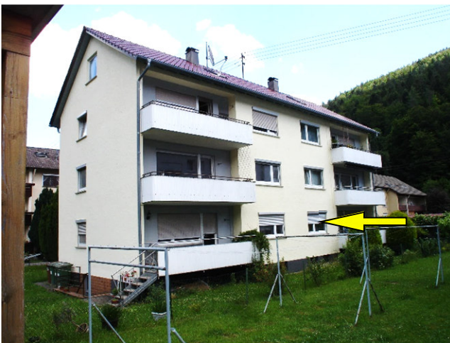
Foto Nr. 5: Ansicht von NW vom Nachbargrundstück (mit Kennz. der Wohnung Nr. 2)
