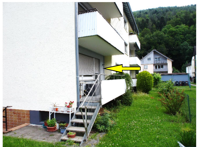
Foto Nr. 6: Ansicht von Nordwesten vom Grundstück (mit Kennz. der Wohnung Nr. 2)
